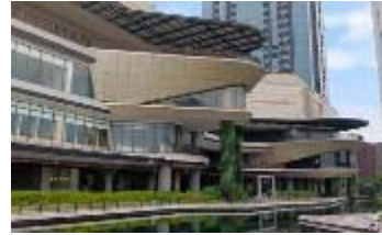
Gambar 8. Fasad Sisi Barat LAMSS Sumber: Dokumentasi Penulis, 2025
