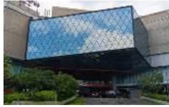
Gambar 7. Fasad Sisi Timur LAMSS Sumber: Dokumentasi Penulis, 2025
