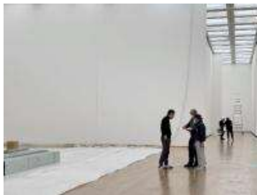
Gambar 8. Pemasangan Partisi Sumber: NACT_PR (Aplikasi X)
