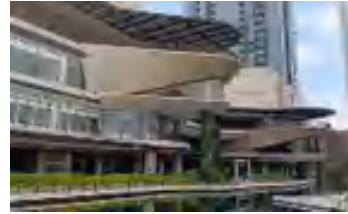
Gambar 8. Fasad Sisi Barat LAMSS Sumber: Dokumentasi Penulis, 2025
