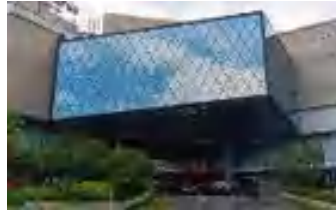
Gambar 7. Fasad Sisi Timur LAMSS Sumber: Dokumentasi Penulis, 2025
