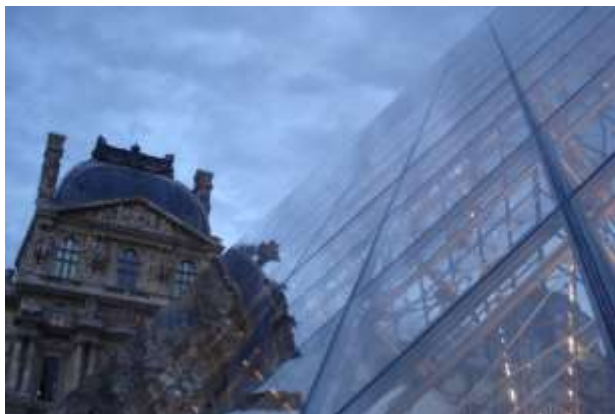
Gambar 2. Material Kaca dan Kerangka Baja Pada Louvre
