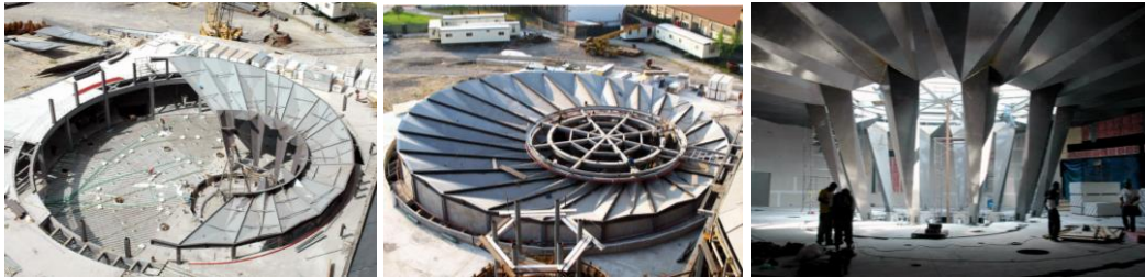
Gambar 12. Proses Pembangunan Museo Del Acero Horno3 [7]
