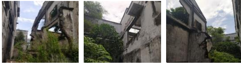
Gambar 7. Kondisi fisik bangunan Eks RRI
