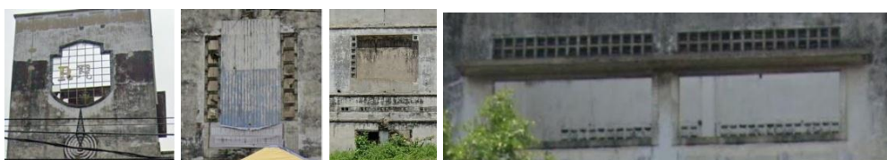
Gambar 5. Kondisi fisik bukaan pada bangunan Eks RRI
